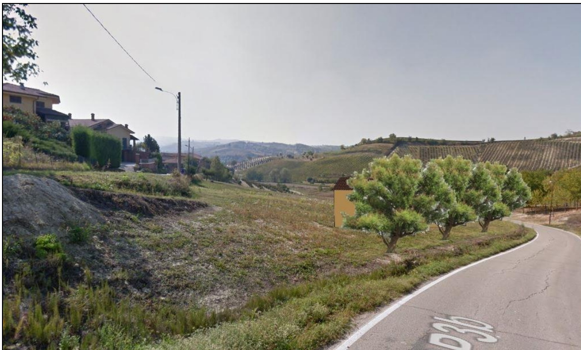
Area di completamento C24 post intervento
